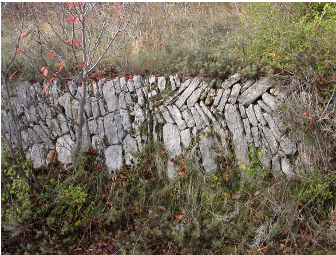
Figura 7 - tratto di muretto a secco in località Mazzurega
